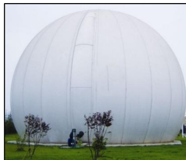
Figura 22 - Gasômetro
